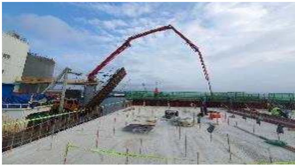
케이슨 상치콘크리트 타설
