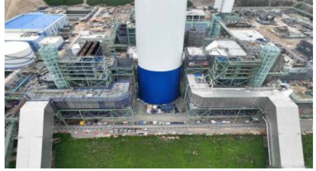
탈황 흡수탑 설치
