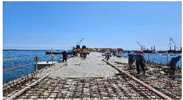
진입가대 콘크리트 타설
