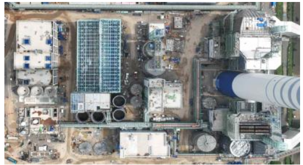
탈황설비 및 Pipe Rack 설치
