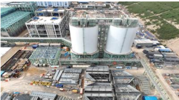
Fly Ash Silo 설치
