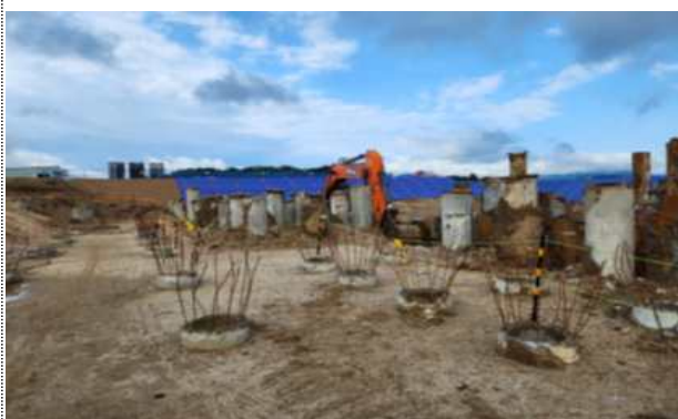
G/T 구간 바닥정리 및 터파기(2구간)
