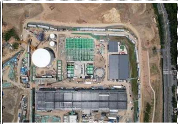
수처리동 및 냉각탑 공사
