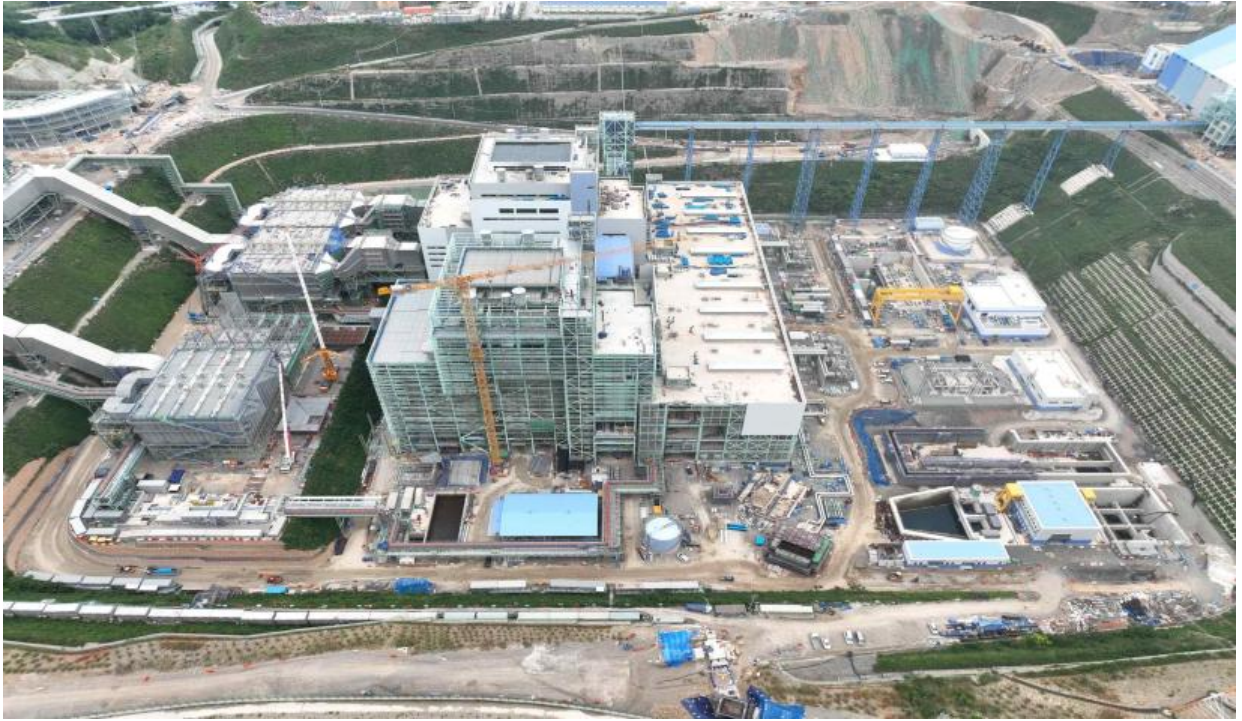
본부지 시공 전경
