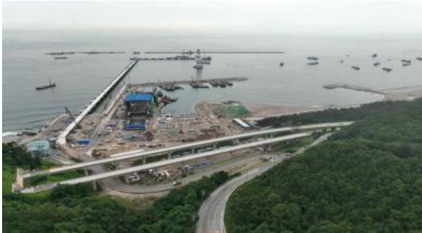
항만 공사 전경
