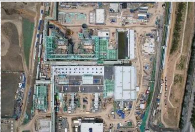
가스터빈동 및 스팀터빈동 공사
