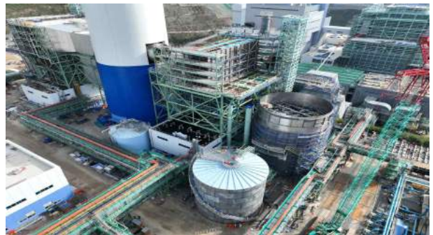
#2 탈황 흡수탑 설치
