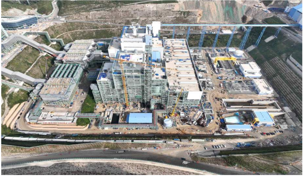
본부지 시공 전경
