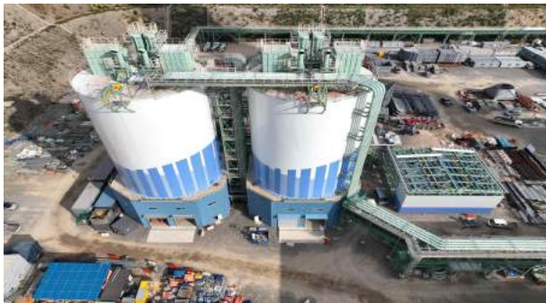
Fly Ash Silo 설치
