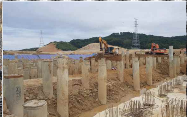
[발전소] HRSG동 굴착 작업
