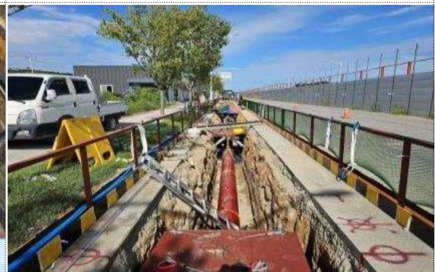
[NG공급] 7구간 도로터파기 및 배관부설
