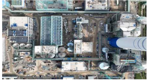
탈황설비 및 Pipe Rack 설치
