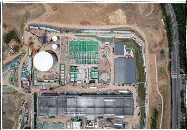
수처리동 및 냉각탑 공사
