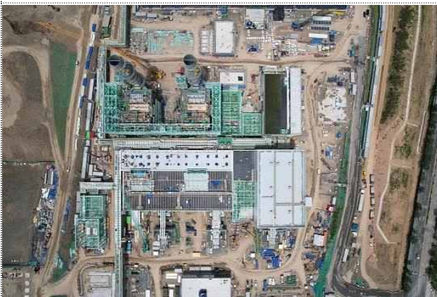
가스터빈동 및 스팀터빈동 공사
