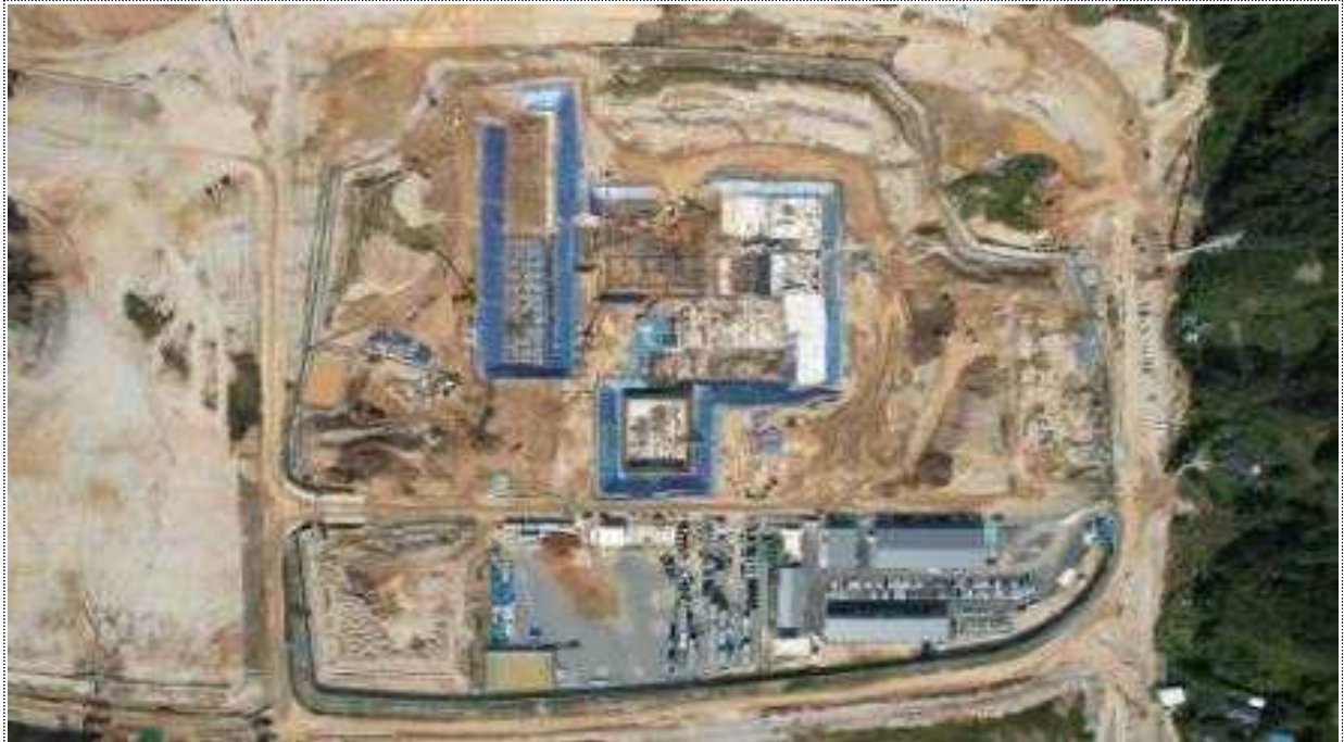
구미천연가스발전소 부지 전경
