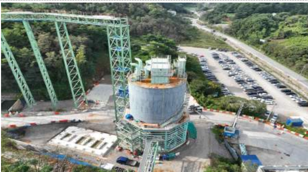
Fly Ash Surge Hopper 설치
