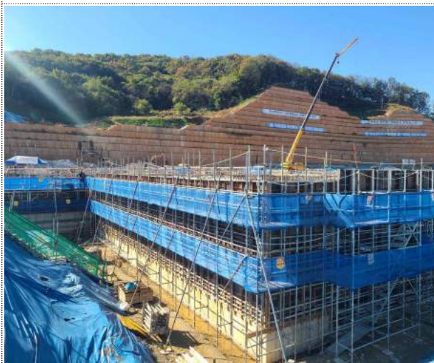
냉각탑 부지 전경
