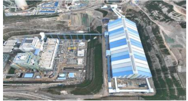
석탄이송설비(상탄) 설치 완료
