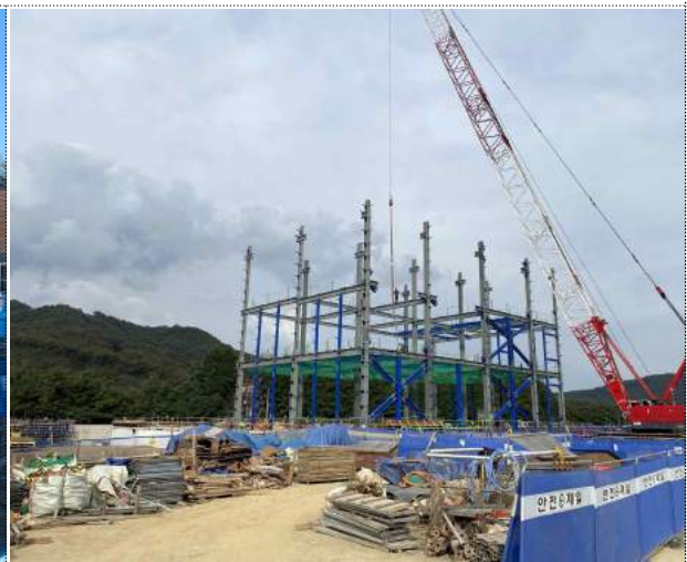
주제어동 철골 설치
