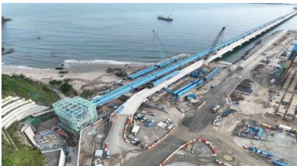
해상 석탄이송설비 설치
