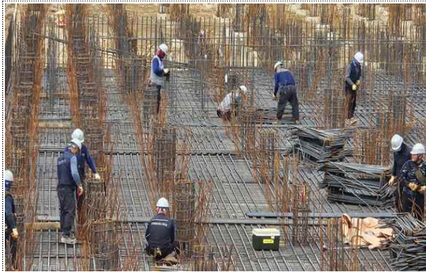
[발전소] 냉각탑 1구간 기초 철근 조립
