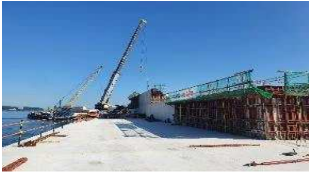
케이슨 상치콘크리트 타설
