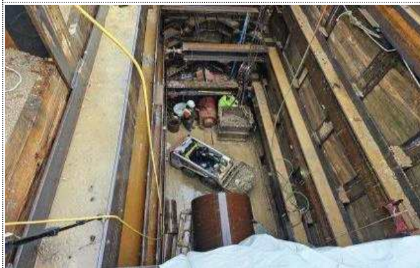
[NG공급] 6구간 압입부 터파기 및 강관설치
