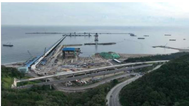
항만 공사 전경
